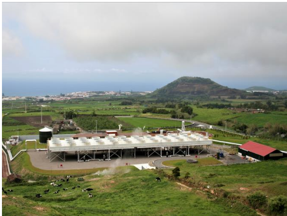
Figure 2: 10 MW Pico Vermelho power plant.
